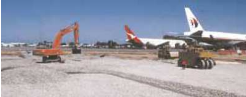
Nueva pista de rodaje en el Aeropuerto de Adelaida (Australia)
