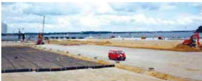
Las geomallas triaxiales son adecuadas para pavimentos en muelles (Letonia)
