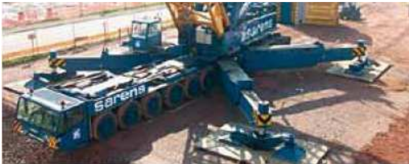
Grúa de gran tonelaje sobre una plataforma de trabajo estabilizada con geomallas triaxiales
