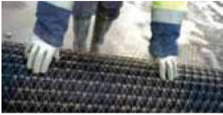
Instalación de la geomalla triaxial en obra
