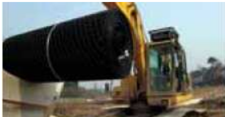
La geomalla triaxial puede ser instalada con maquinaria o por dos personas
