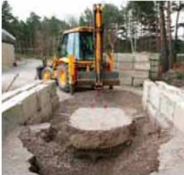
Excavación para el ensayo de daños durante la instalación de geomalla triaxial en el TRL
